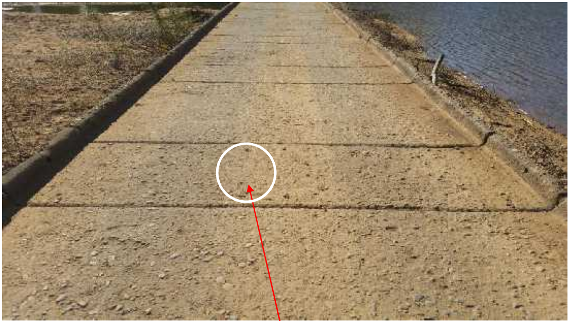
140011 – Longitudinal crack
