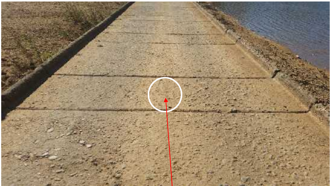
135954 – Longitudinal crack
